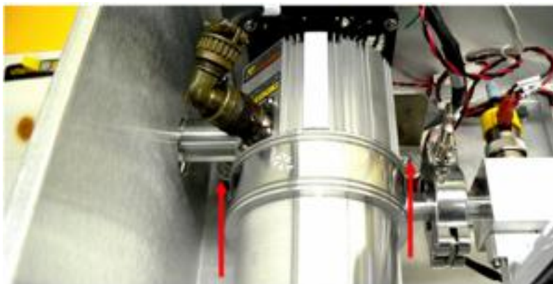
Рис. D-6. Гайки на стойке насоса
